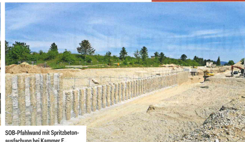
Pfahlwand mit verrohrten Bohrspählen DN 120 cm.
