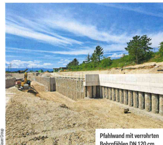
SOB-Pfahlwand mit Spritzbetonausfachung bei Kammer E.
