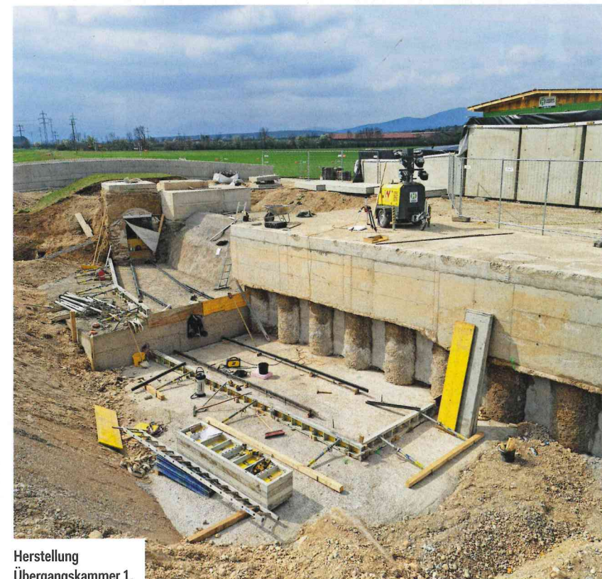
SOB-Pfahlwand mit Spritzbetonausfachung bei Kammer E.
